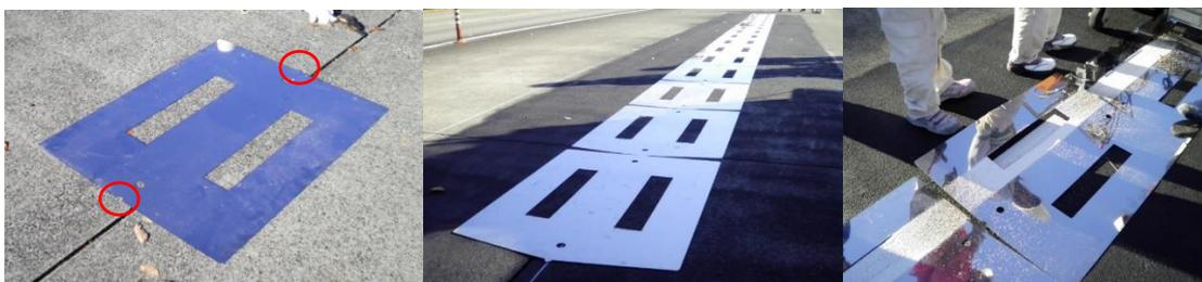
図 3-15 誘導線の効率的な施工方法（イメージ）
