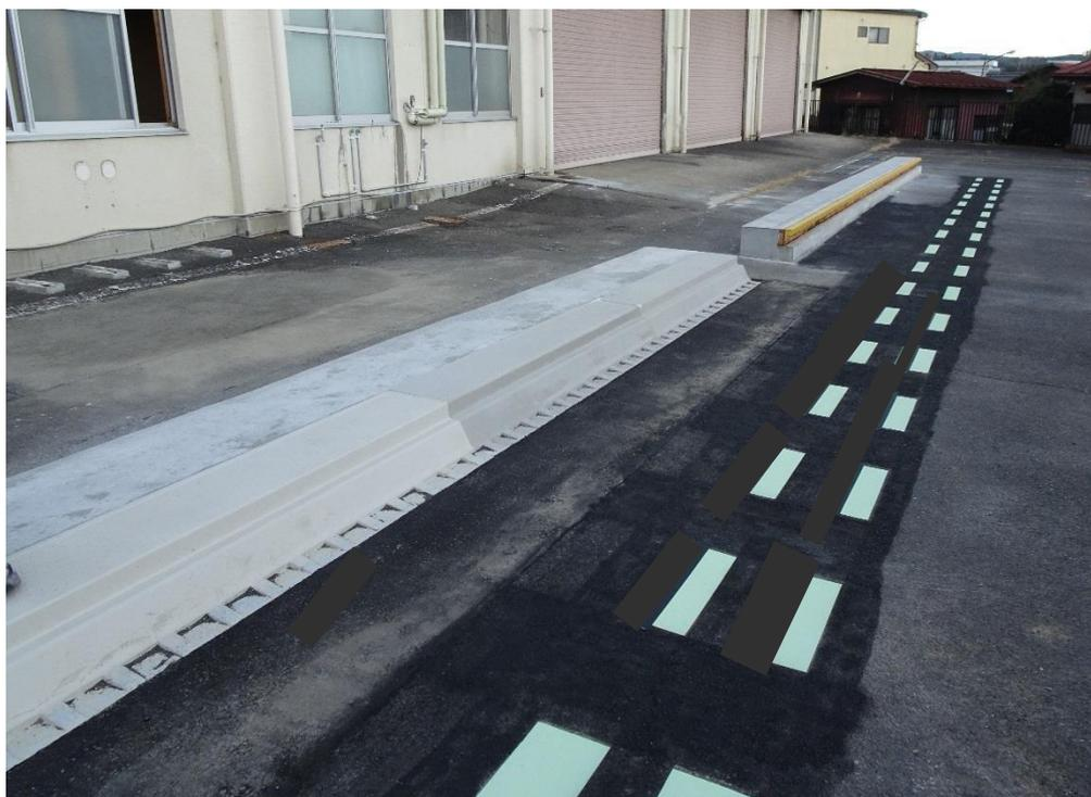
図 3-12 誘導線とプラットフォームの設置状況
