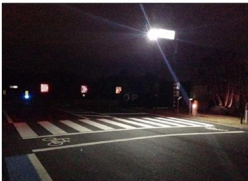
図 4-12 道路空間安全照明 (センサー別置対応型)
