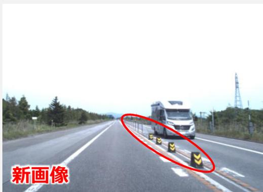
実例① 暫定二車線区間の分離構造の変化（ワイヤーロープ設置）
