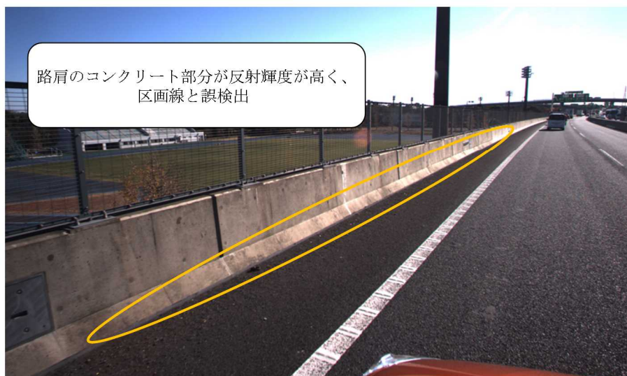
図 3.1-33 路肩コンクリートによる区画線の誤検出例
