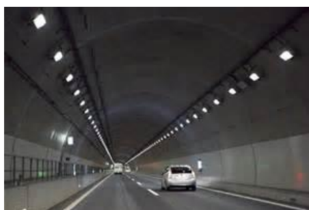
d)トンネル
