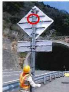
上部に転倒防止ロープを設置する
