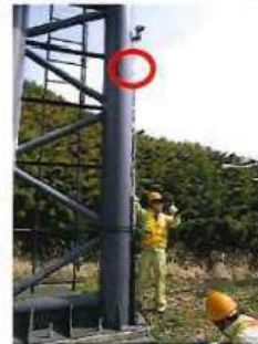
上部に転倒防止ロープを設置する
