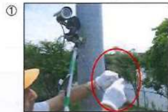
① 固定用ロープを設置柱に回します 安全対策として転倒防止ロープも設置します
