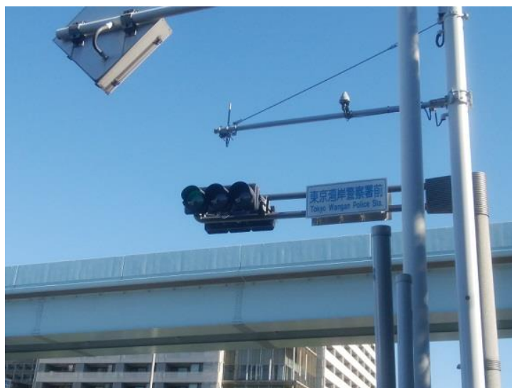
写真 4 700MHz 帯 I T S 無線アンテナ（信号灯器の上部）
