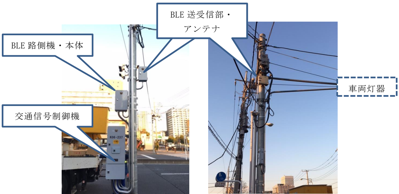
図 4.8 機器設置図 (A 柱)
