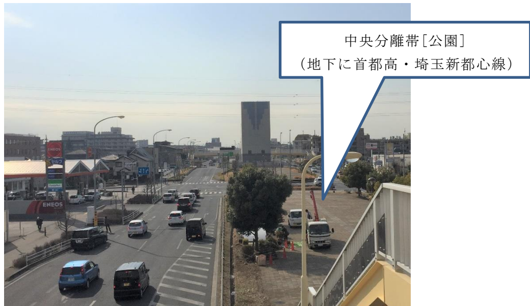
図 4.3 交差点写真（西進方向より）
