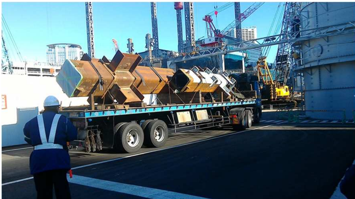
図 4.3.1-6 工事現場と建設車両の資材搬入の様子
