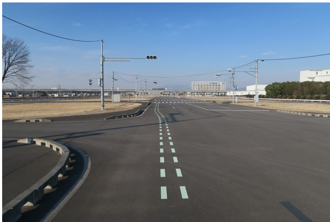
図 5-3 誘導線①（緑）設置状況
