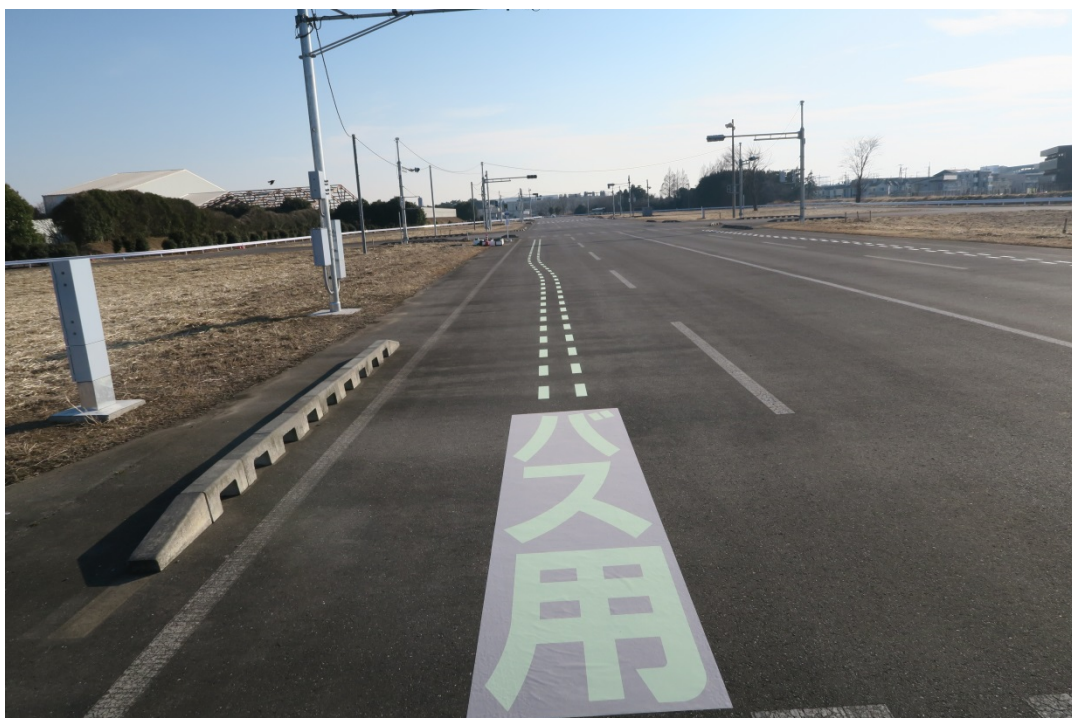
図 5-5 誘導線③（注記）設置状況
