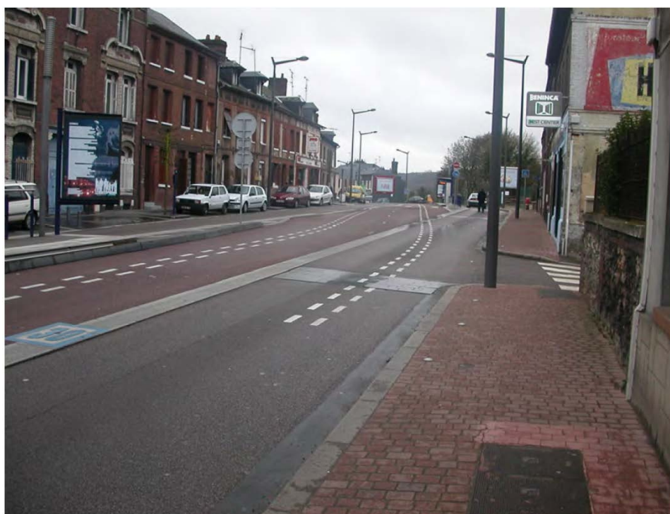
図 2-2 TEOR（ルーアン東西交通）で採用されている誘導線の写真
