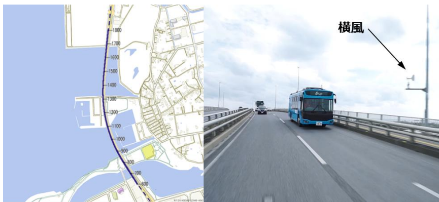
40km/h超走行区間（国道331号線:豊崎～瀬長間）
