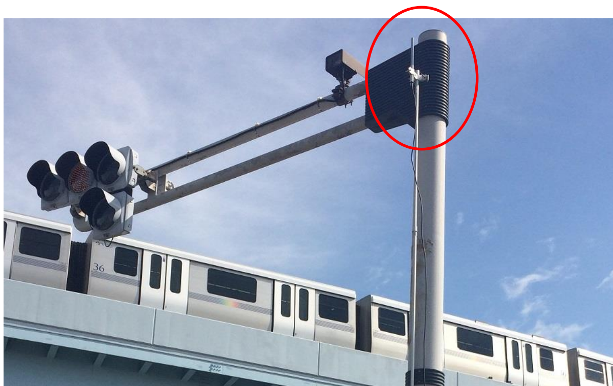
写真 3.1 送信アンテナの信号柱への仮設例（赤丸内が、送信アンテナ）
