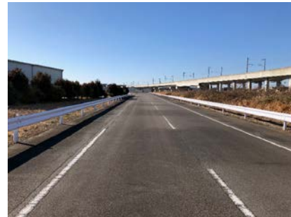
D. 路面状況（白線のかすれ）
