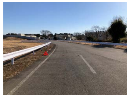
F. 故障車両による車線減少
