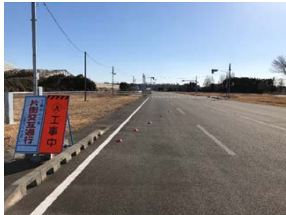
A. 工事現場による車線減少
