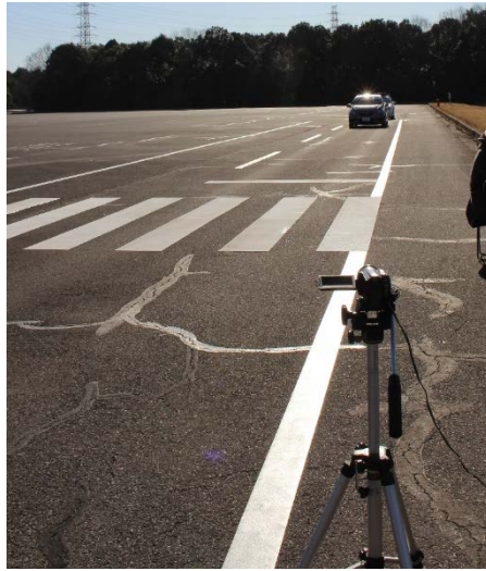
図 5-5 無信号横断歩道付近に設置した映像記録用カメラ
