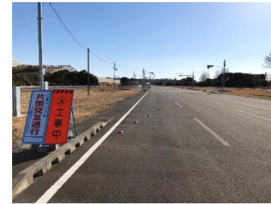
工事現場による車線減少場面
