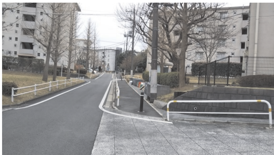
図表 永山団地内のみなし公道の状況
