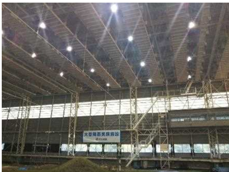
大型降雨実験施設
