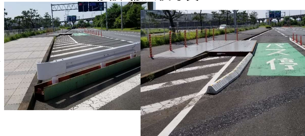
移設・撤去後写真
