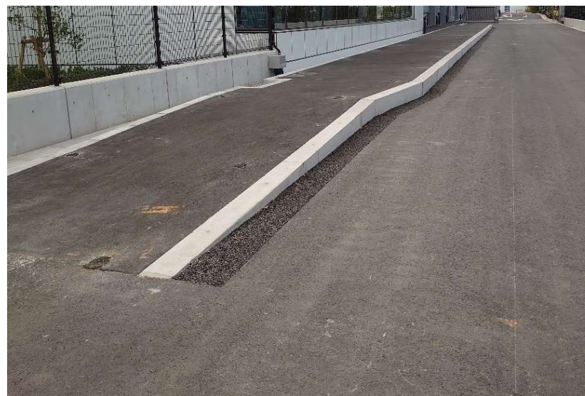
第1ゾーンバス停 横断防止柵撤去後
