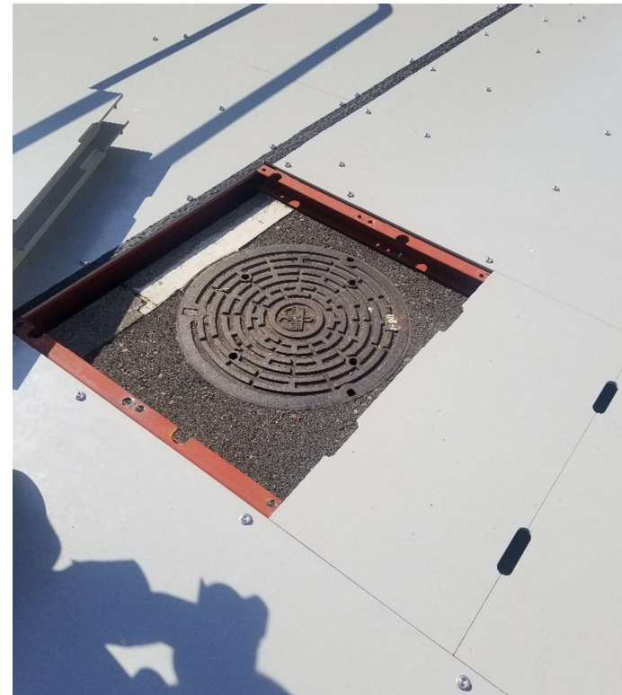
マンホール部写真
