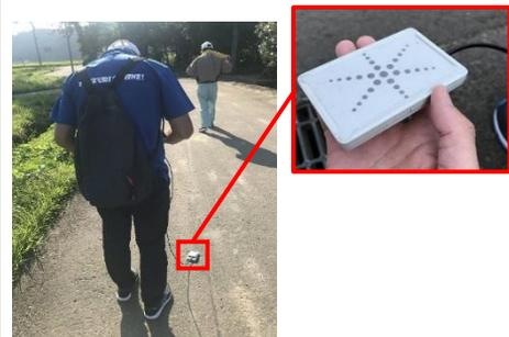
インフラ(電磁誘導線、RFタグ)の点検
