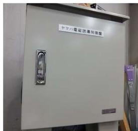
図 3-59 電磁誘導線への給電設備ならびに内回り/外回りの切替装置
