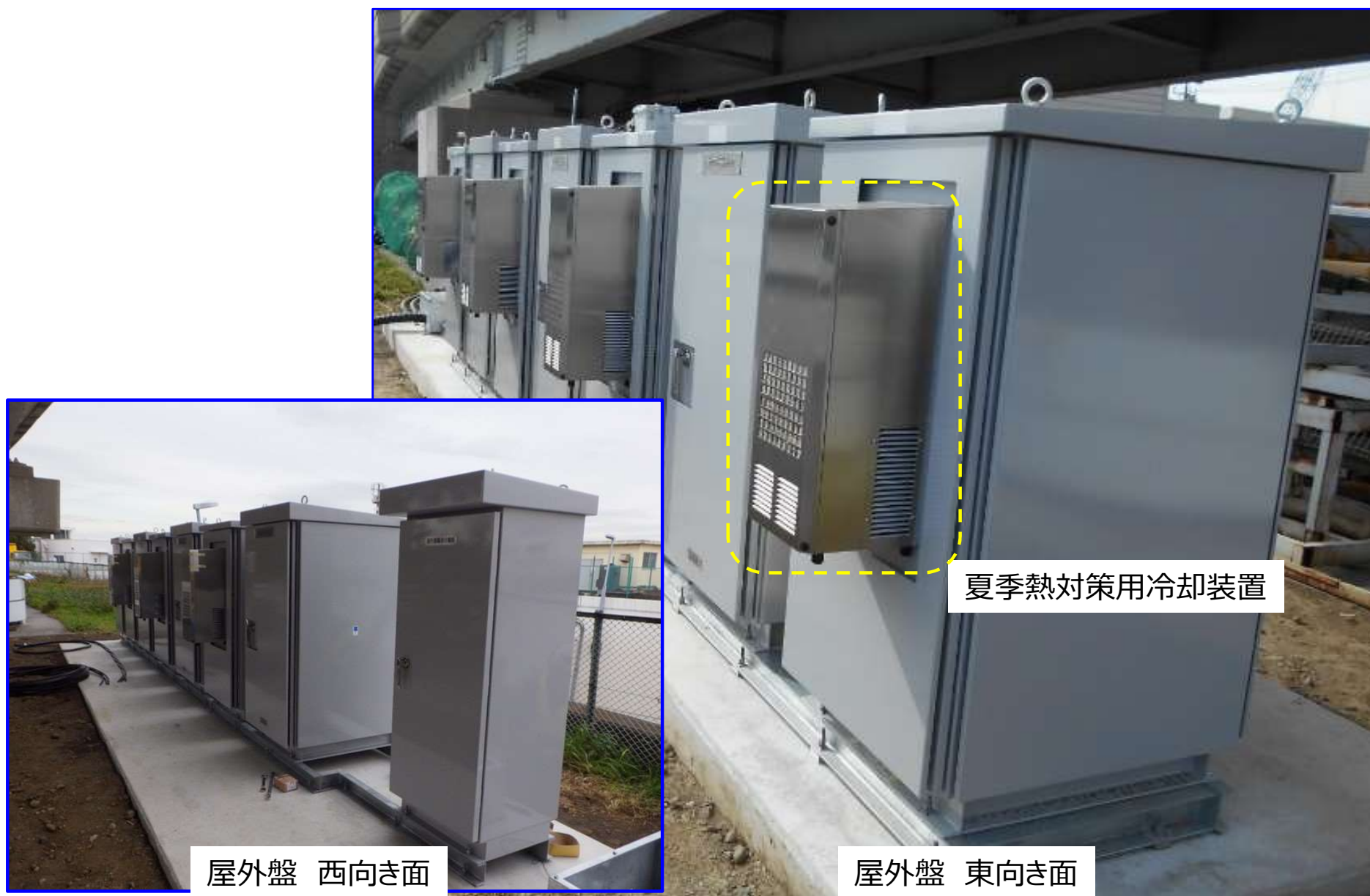
図3-6 ETCゲート通過支援情報提供管理サーバ及び、センサメーカー各社の路側処理装置を格納した屋外盤外観
