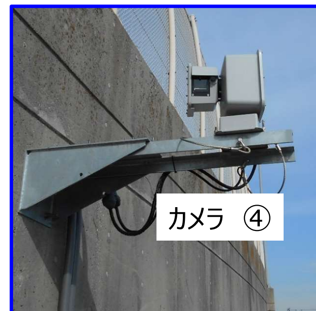
図3-7 本線及び合流部の交通状況を撮影する各カメラ装置
