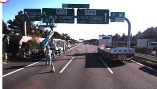
⑤ 谷田部IC→つくばJCT(工事中でレーンチェンジ)
