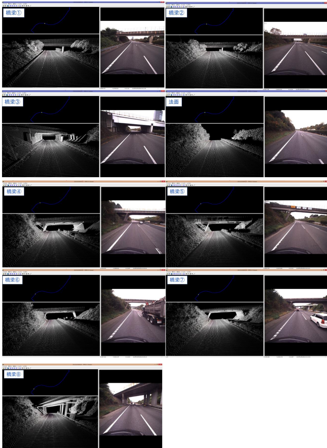
図 6.5.2-3 区間 B の橋梁、法面の様子(MMS データより)
