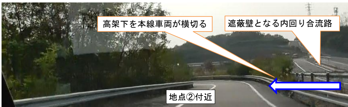
図 5.2.4.2-19 合流路の様子（東海環状：豊田勘八 IC）
