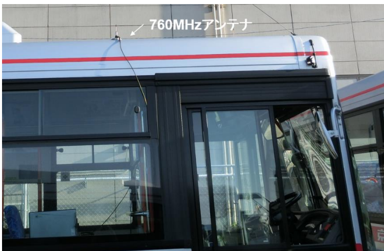
図 5-8 6 バス機材設置状況 1
