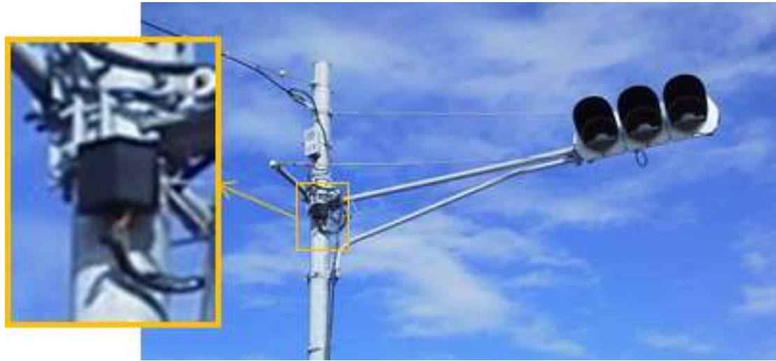
図 7.1-1 テストコースにおける信号機支柱への仮設置状況
