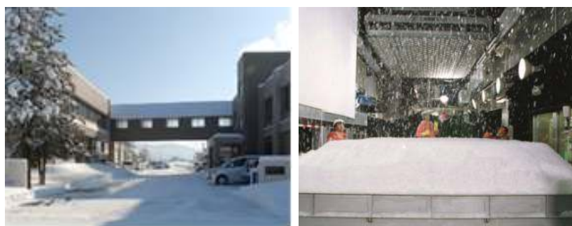
図 5.3.2-27 雪氷防災実験棟の大型低温室[1]
