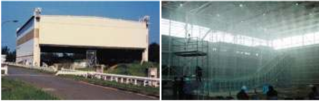
図 5.3.2-1 大型降雨実験施設[1]
